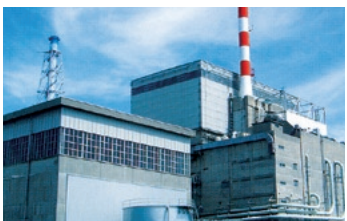
廃止措置が進む東海発電所
